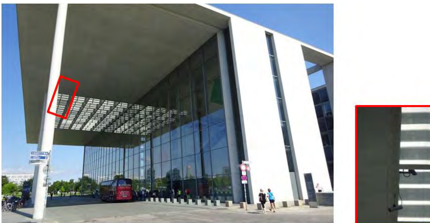
Abb.5.3.1.2 Bürogebäude Deutscher Bundestag Berlin, Kameras unter der Vordachdecke
