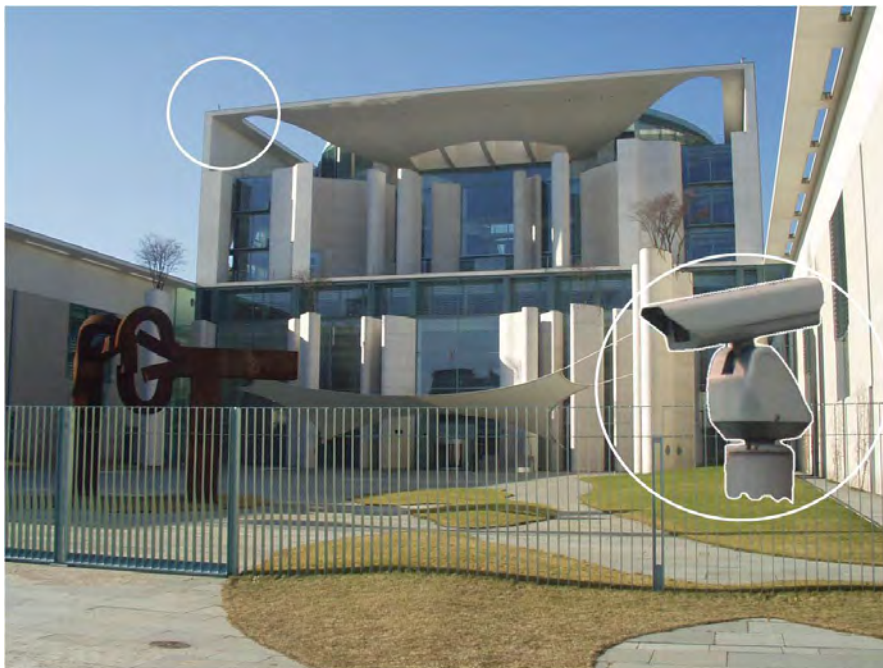
Abb. 5.4.1 Bundeskanzleramt Berlin, Schwenk-/Neigekameras auf dem Dach
