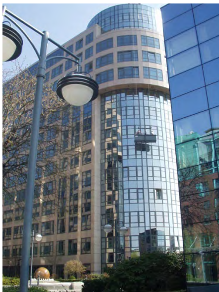
Abb. 5.1.4.1 Ehemaliges Gebäude des Bundesinnenministeriums in Berlin Moabit
