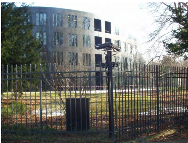
Abb. 5.1.3.1 Kameramaste um das Gebäude, Perimeterüberwachung Bundeskanzleramt Berlin
