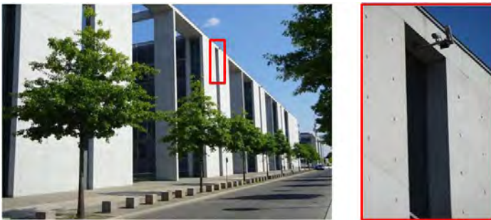
Abb. Abb. 5.3.1.1 Bürogebäude Deutscher Bundestag Berlin, Fassaden- und Detailansicht
