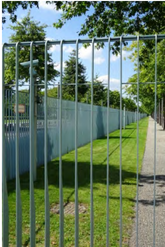
Abb. 5.1.2.1 Kameramaste um das Gebäude, Perimeterüberwachung Bundeskanzleramt Berlin
